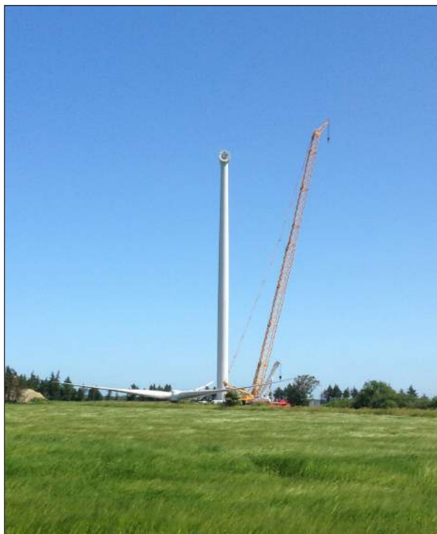
Figur 4.5 Opstilling af vindmølle med mobilkran.
