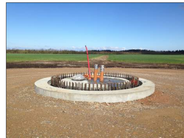
Figur 4.4 Færdigt fundament klar til vindmølleopstilling.
