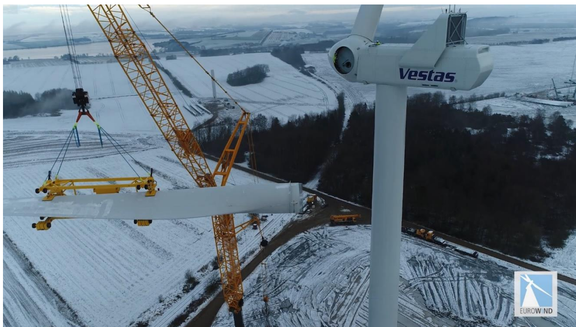
Foto: Arbejdsplads med kran under opførelse af Vestas vindmølle (Eurowind Project A/S).
